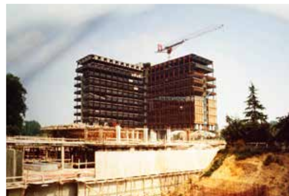
beeld van de opbouw in de jaren 1967-1970 _image de la construction dans les années 1967-1970
