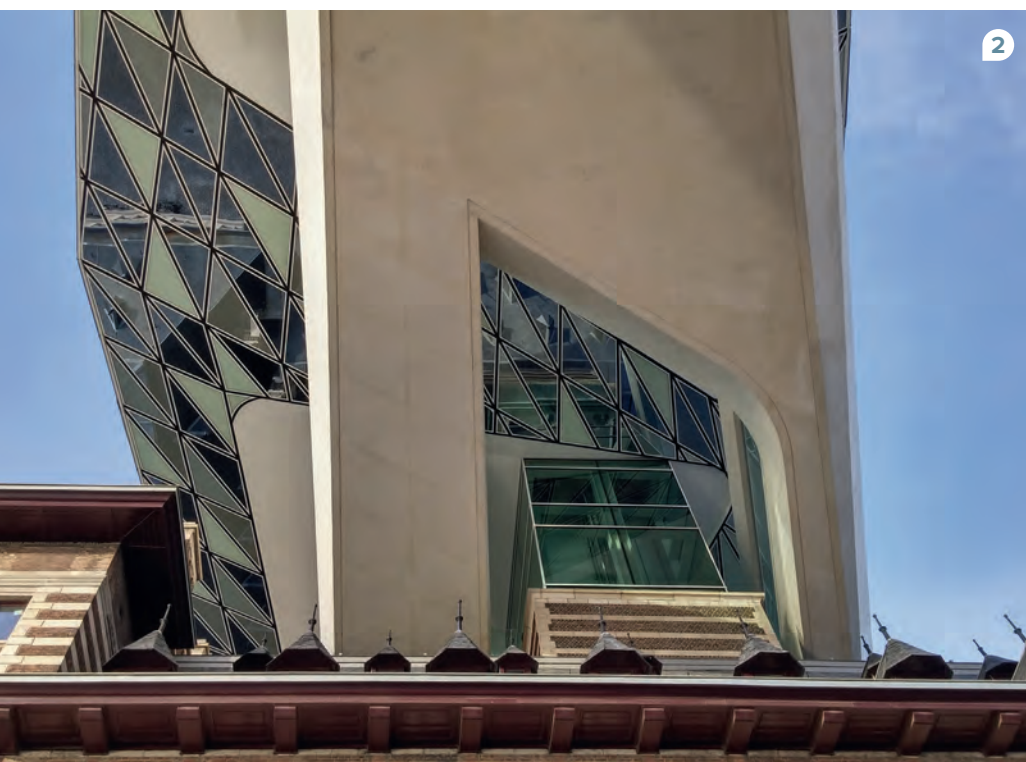
1 // De sculpturale pijler onder de voorsteven is zeer strak uitgevoerd in zelfverdichtend wit beton.
