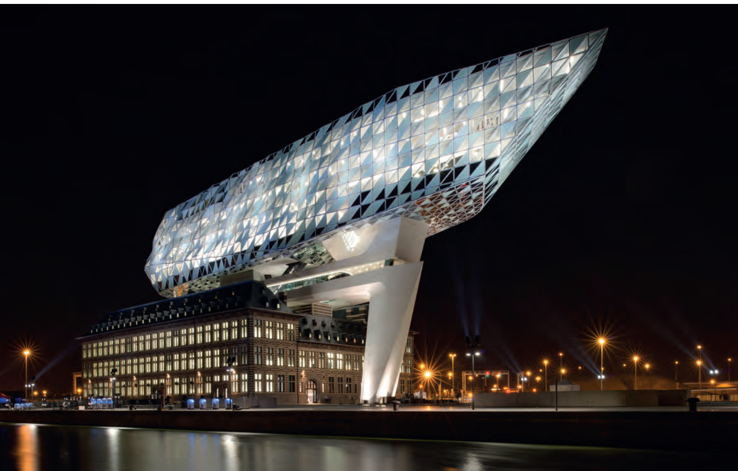
De uitzonderlijk gedetailleerde aansluiting van de glazen opbouw op de betonnen constructie met het uitzichtdek is zeker bij avond goed te zien.
