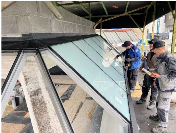
Figure 6 - Auvent temporaire pour le renouvellement des éléments de menuiserie
