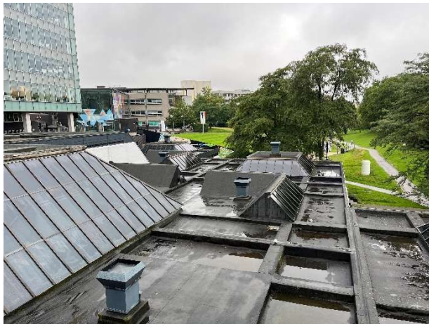
Figure 1 - État avant rénovation
