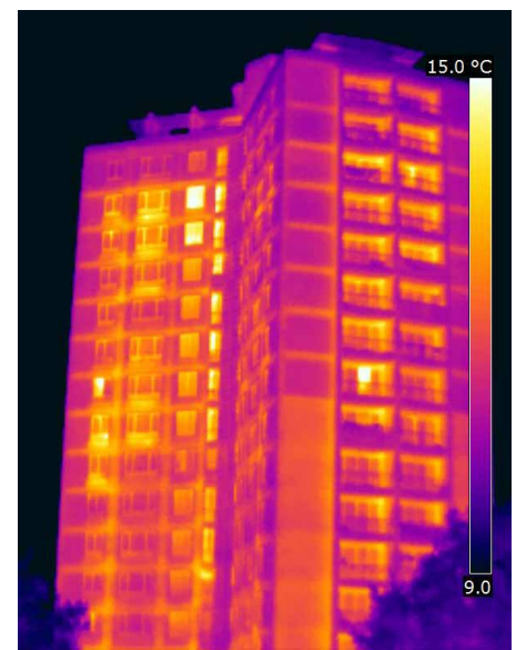
▲ Naast een structurele analyse werd ook een uitgebreide set van energetische monitoring opgezet, waaronder de thermografie van het gebouw.
