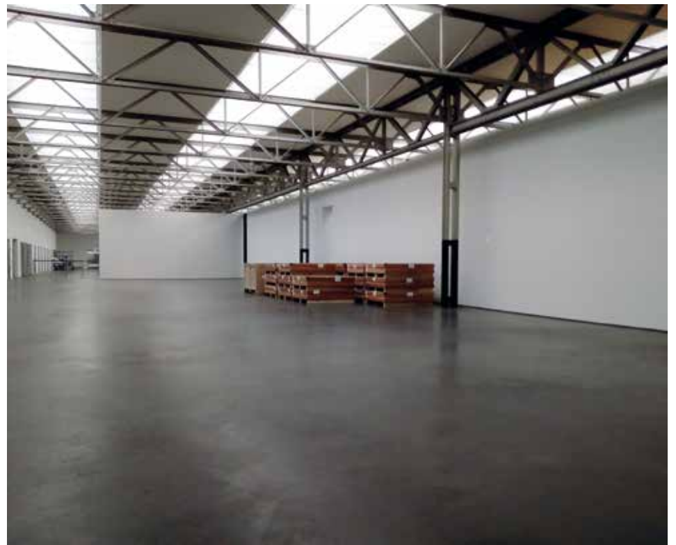
Sheddak De Pont - Tilburg met verstrooiing voor egale verlichting tentoonstellingsruimte
