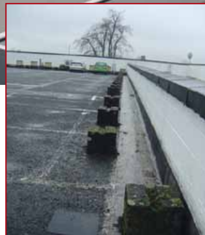
Avant la rénovation
